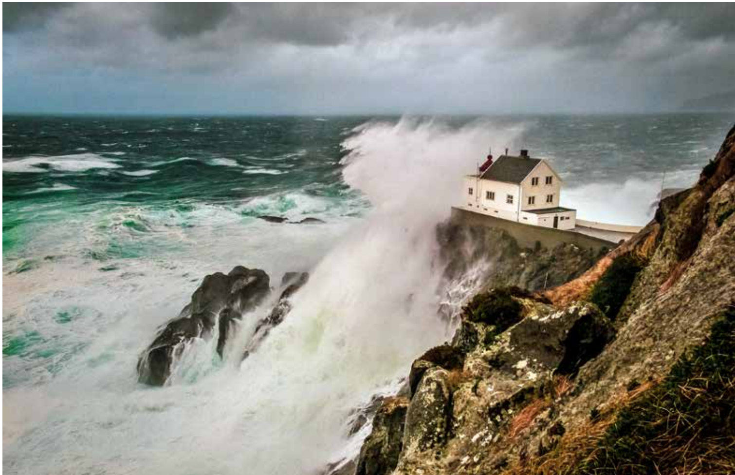
Kråkenes Fyr med vinduer fra Nordvestvinduet
